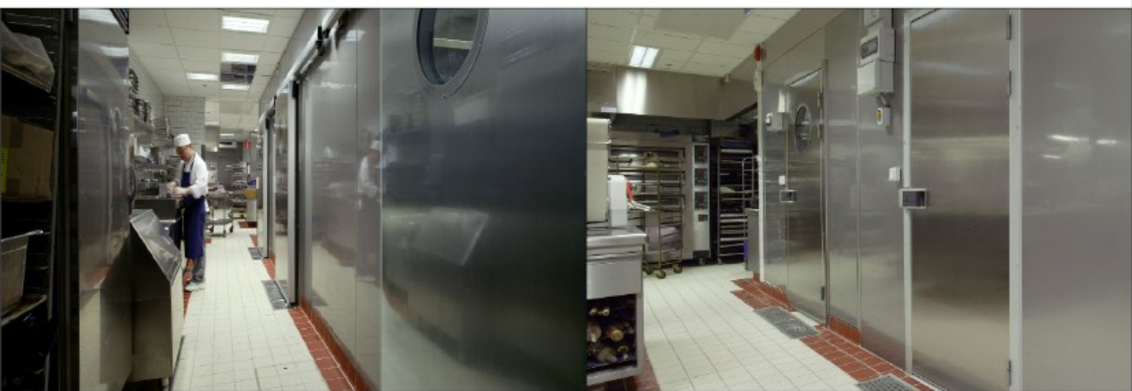
Drzwi chłodnicze i mroźnicze ze stali nierdzewnej.
