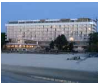
Sanatorium „BAŁTYK”, Kołobrzeg
